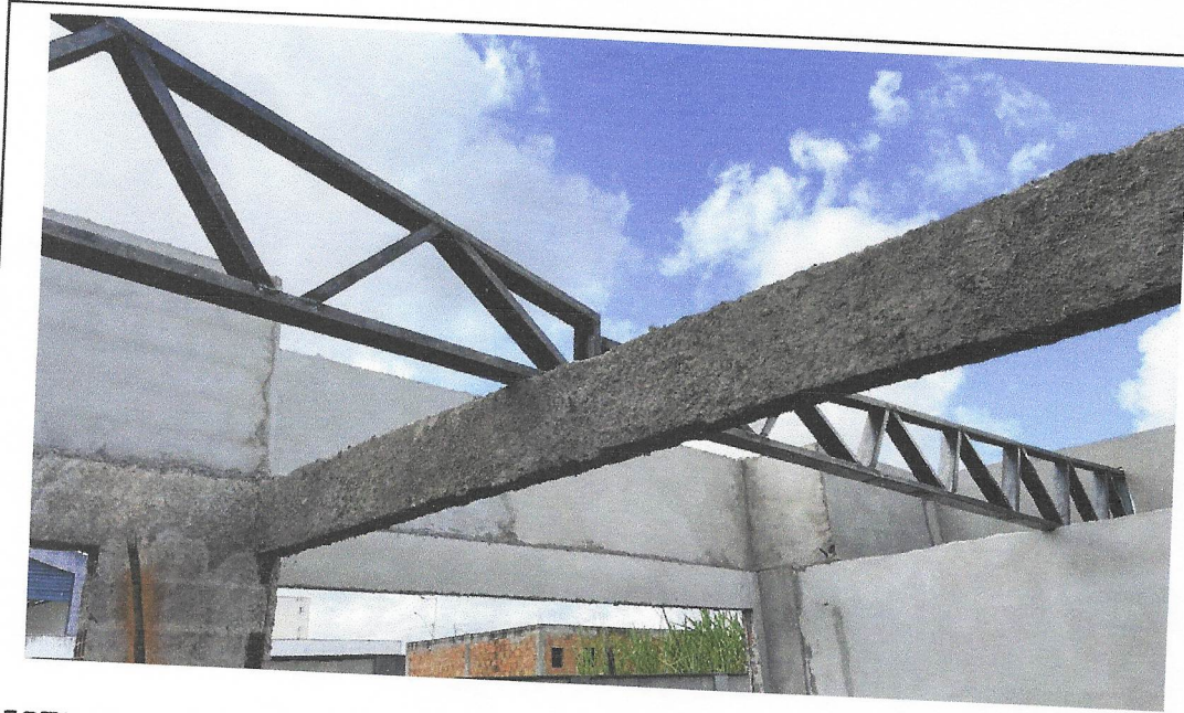
FOTO 63: ESTRUTURA METÁLICA DA COBERTURA
