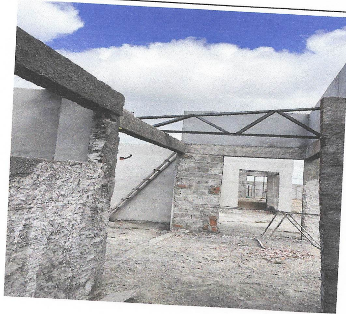
FOTO 63: ESTRUTURA METÁLICA DA COBERTURA
