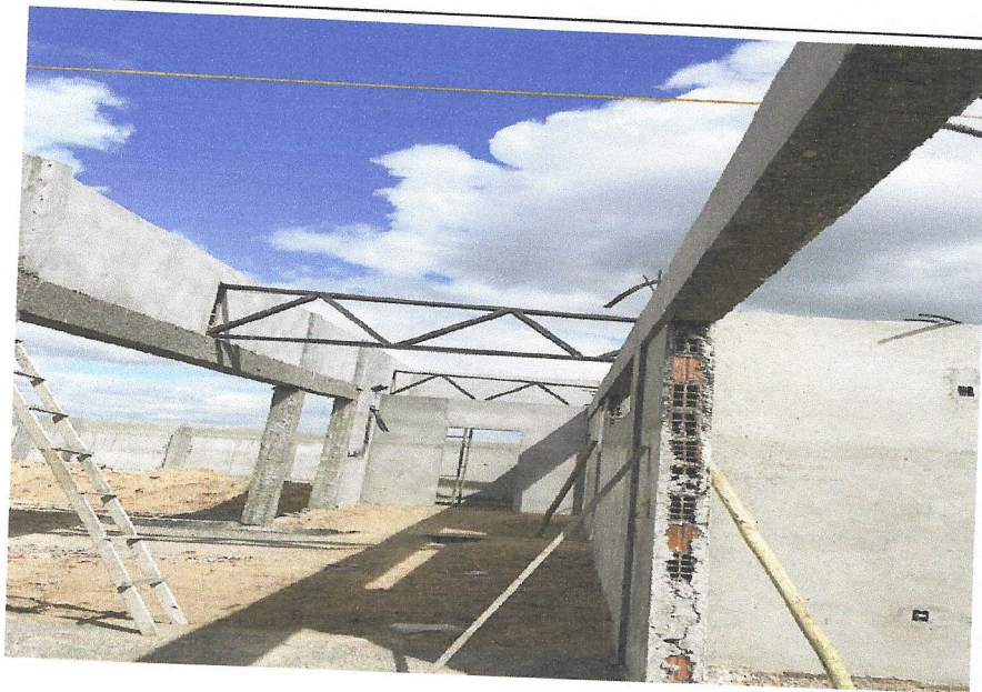
FOTO 64: ESTRUTURA METÁLICA DA COBERTURA
